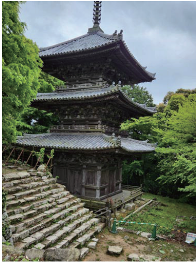
三重塔室町時代の建物で（1454）に建立天文二十四年に信長公が甲賀の長寿寺から移建したものとされている
