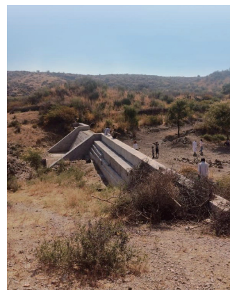
砂防ダムの高さは4.3メートル、基盤の深さは2.1メートル、集水域は幅3〜7キロです
